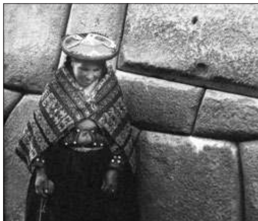
◆ Рис. 6. Многие сооружения инков, сложенные из огромных каменных блоков без скрепляющего раствора, сохранились до наших дней.
